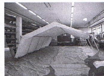
8. Im Bodenbereich die Hacken der Seitenplane in die Metallaschen der Pfostenrohre einhängen und stramm ziehen. Die Metallaschen dabei mit der eingehakten Seite nach außen drehen.
